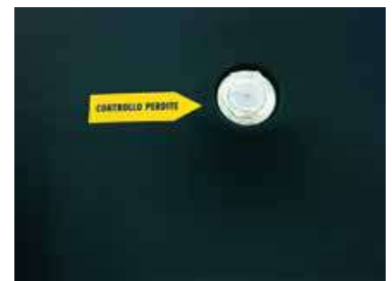
Detector visual de fugas
